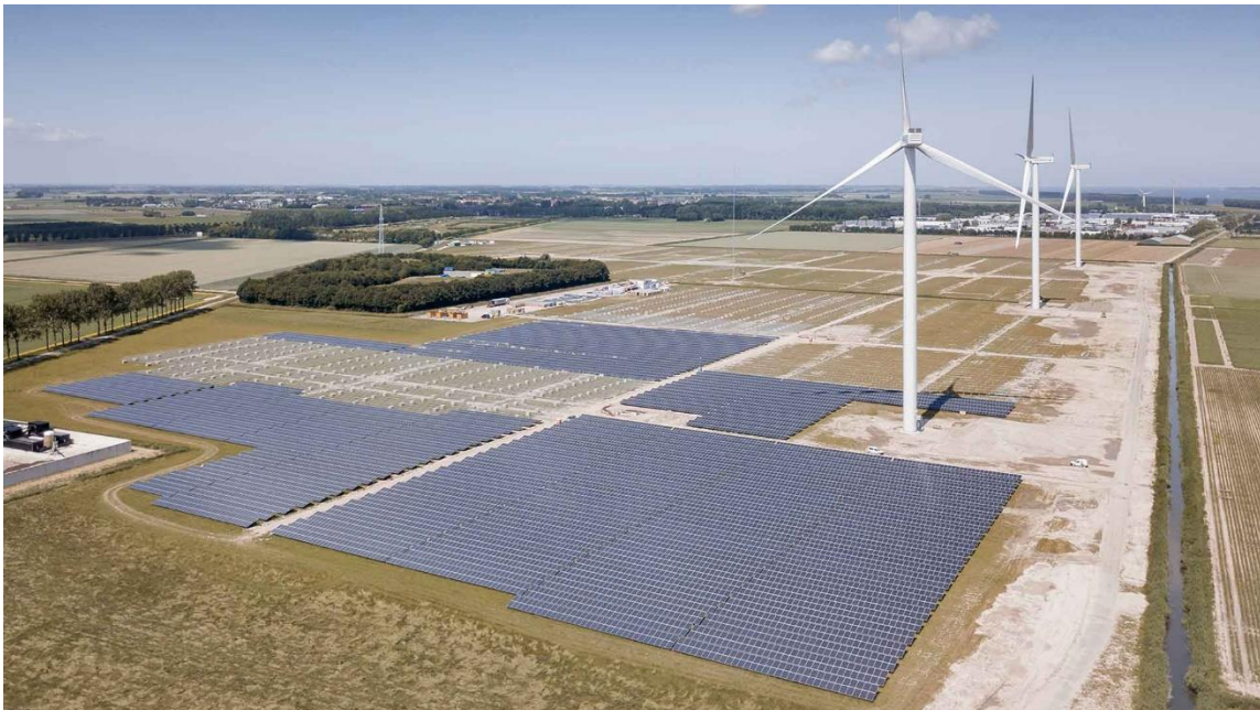
Figure 4-1: Haringvliet Zuid Energy Park. Source: Vattenfall
